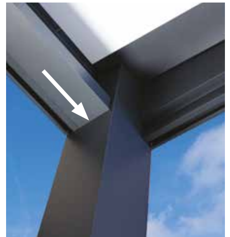
évacuation des eaux via les gouttières placées dans les poteaux
