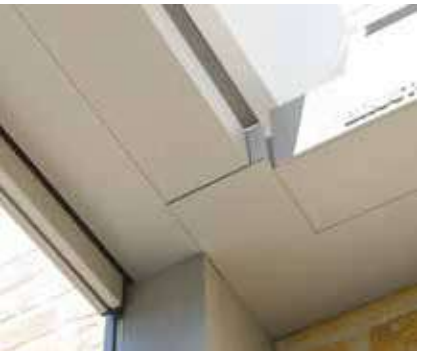
Évacuation des eaux via les gouttières placées dans les poteaux
